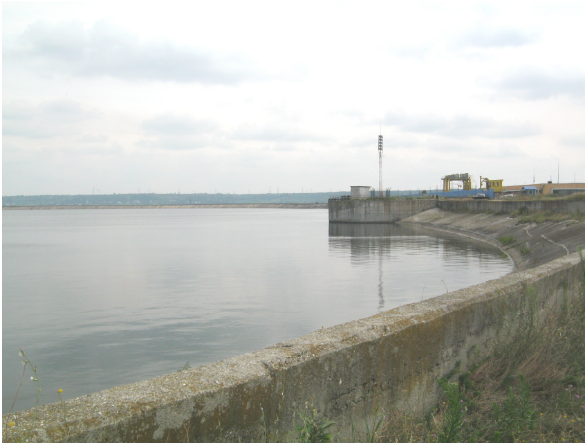
Foto 1 – Amenajarea hidroenergetică Arcești
